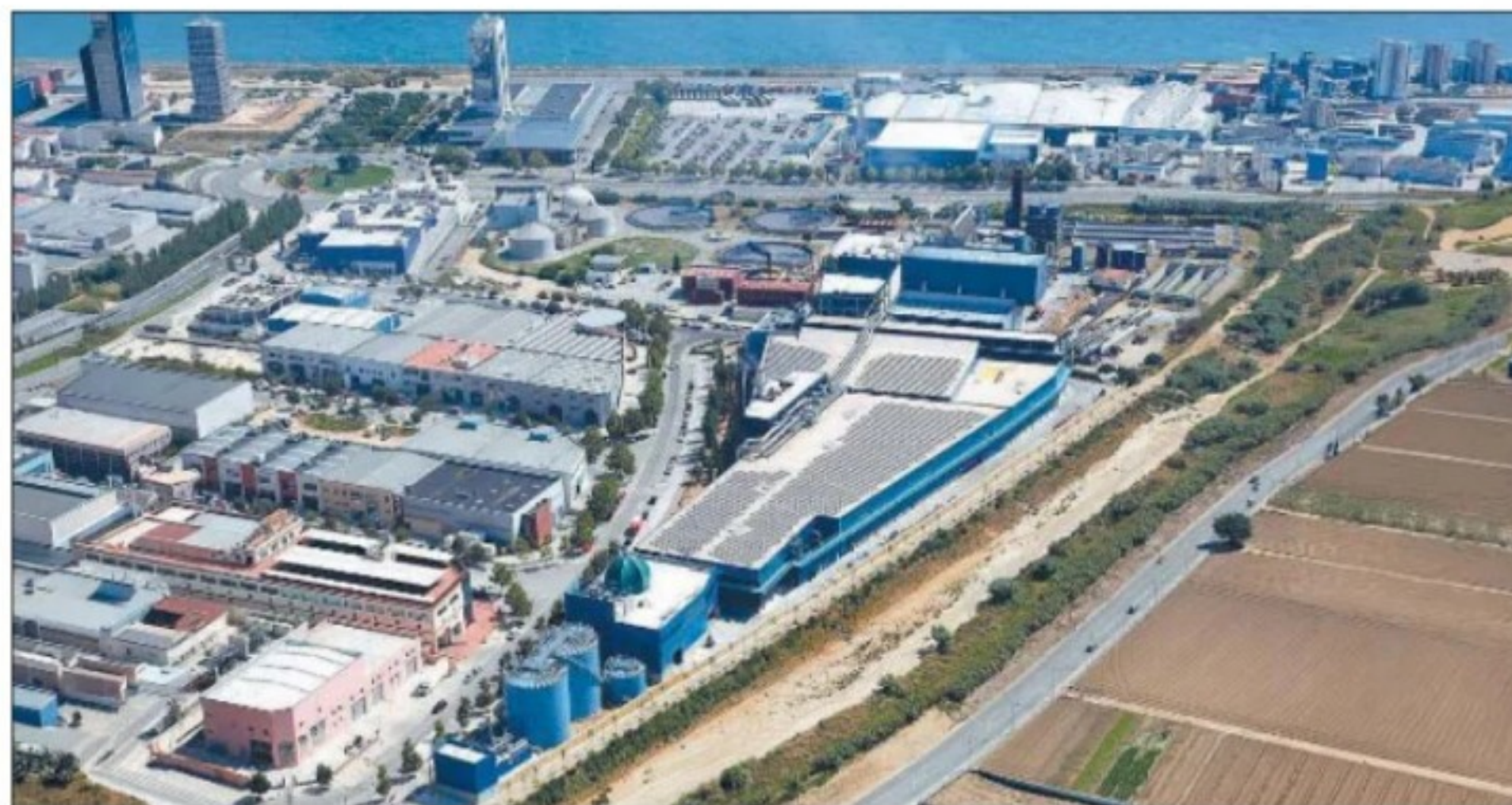
Vista aérea del Centro Integral de Valorización de Residuos del Maresme (Mataró)
