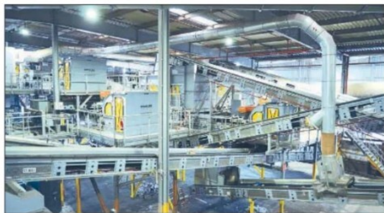
Proceso de tratamiento del Complejo Ambiental de Miramundo (Cádiz)
